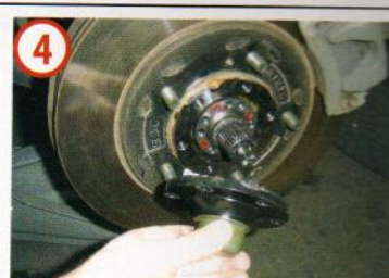
4 Retiramos la pieza original sin que entre suciedad que pueda dañar los rodamientos.
