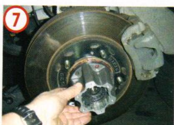
7 Aprovechando los tornillos originales, colocamos el cuerpo del mecanismo de bloqueo.
