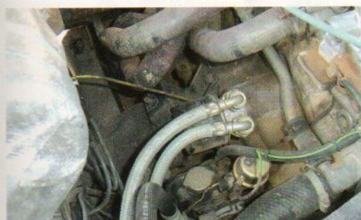
Todo el trabajo se basa en instalar un derivador del flujo de aceite entre el bloque y el filtro.
